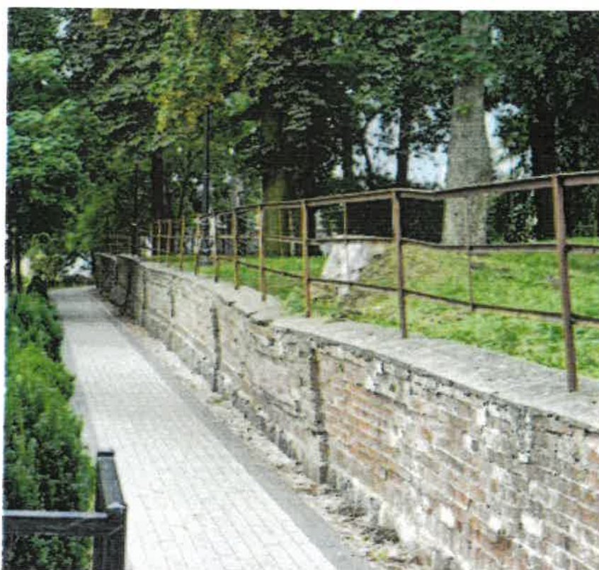
Fot. 2 Fragment muru na odcinku C-D -znaczące odchylenie od pionu
