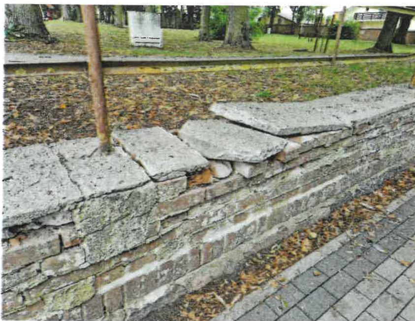
Fot. 1 Zdegradowany murek na odcinku E-F (zniszczona czapka betonowa i zdegradowane cegły)
