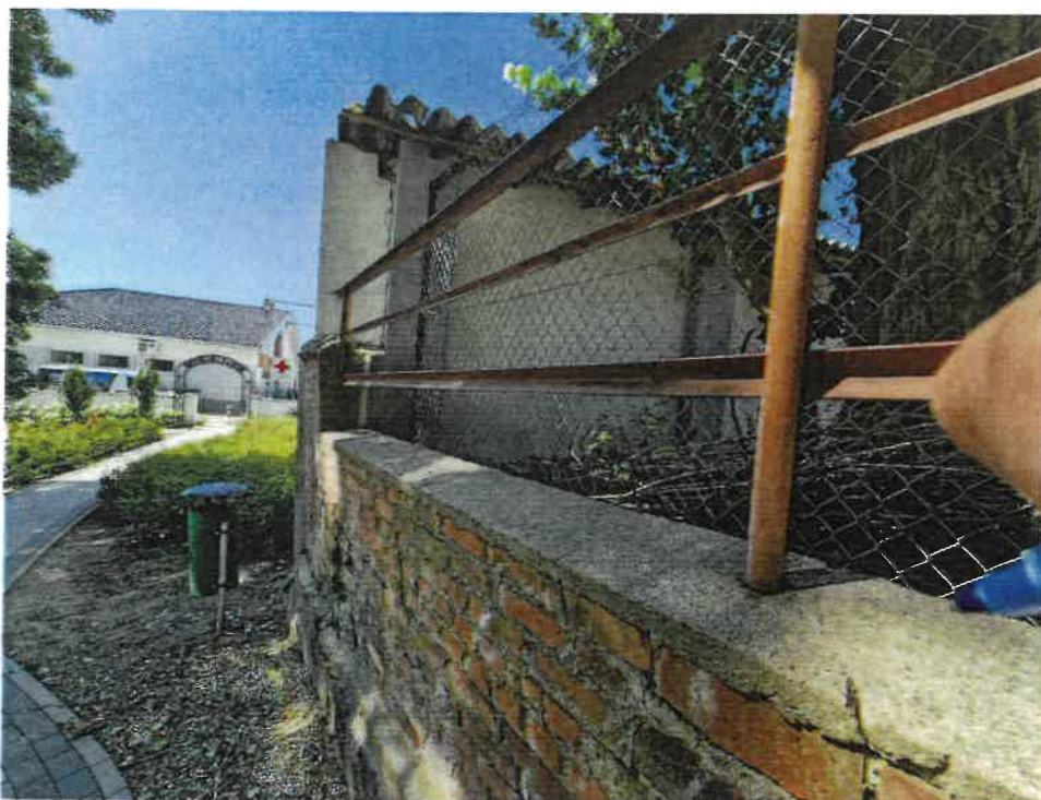
Fot. 3 Fragment muru - cegła wykruszała i o wysokim stopniu zużycia
